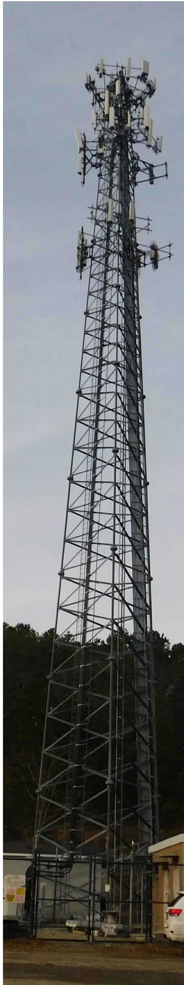
EXISTING TOWER PHOTO 1 SCALE: N.T.S.
