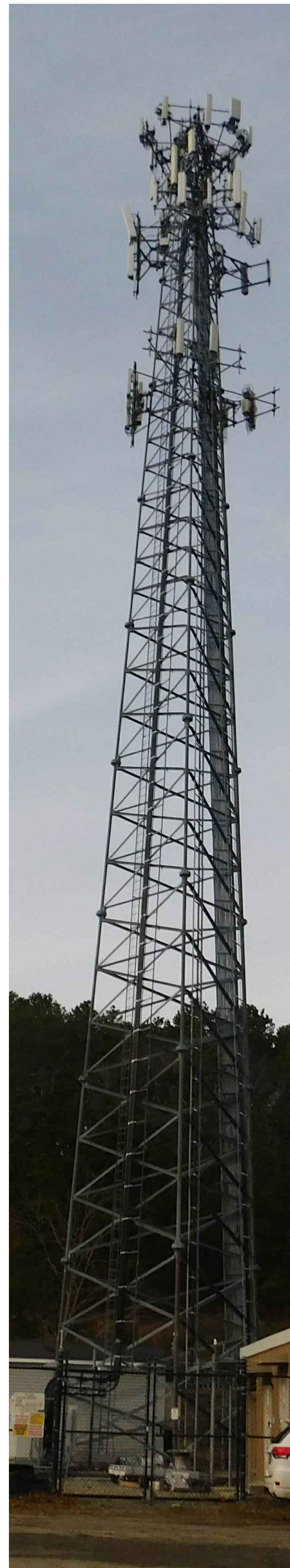
EXISTING TOWER PHOTO 1 SCALE: N.T.S. A-2
